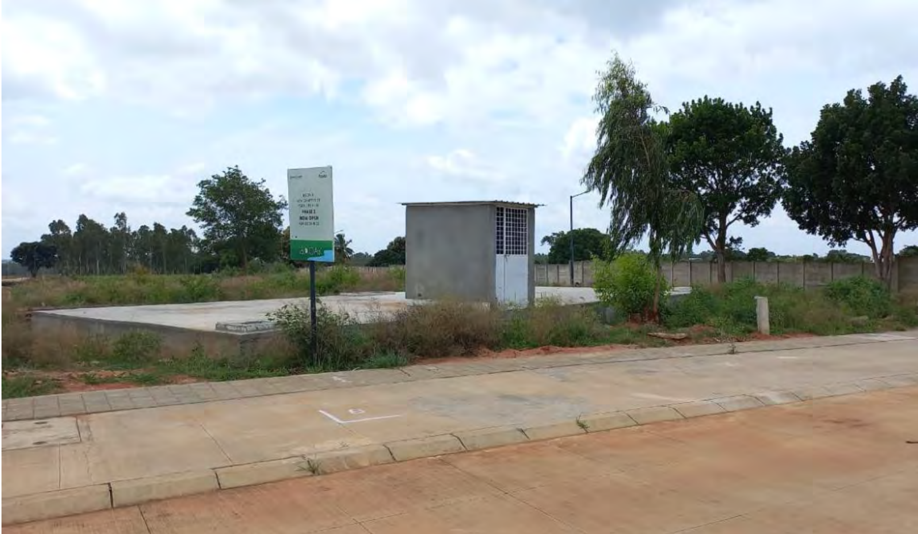
3LCU UG SUMP
