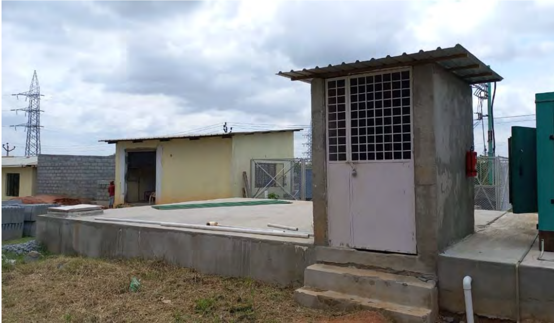
1LCU UG SUMP
