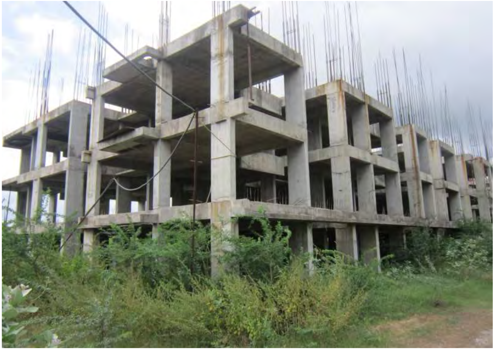
Block E – 3 rd floor slab pour 1 and pour 2 completed
