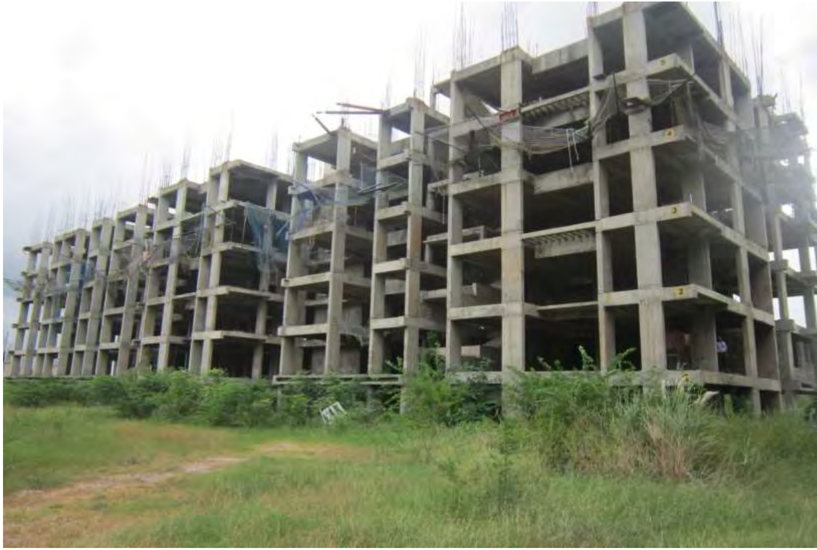
Block B –6 th floor slab pour 1 and pour 2 completed
