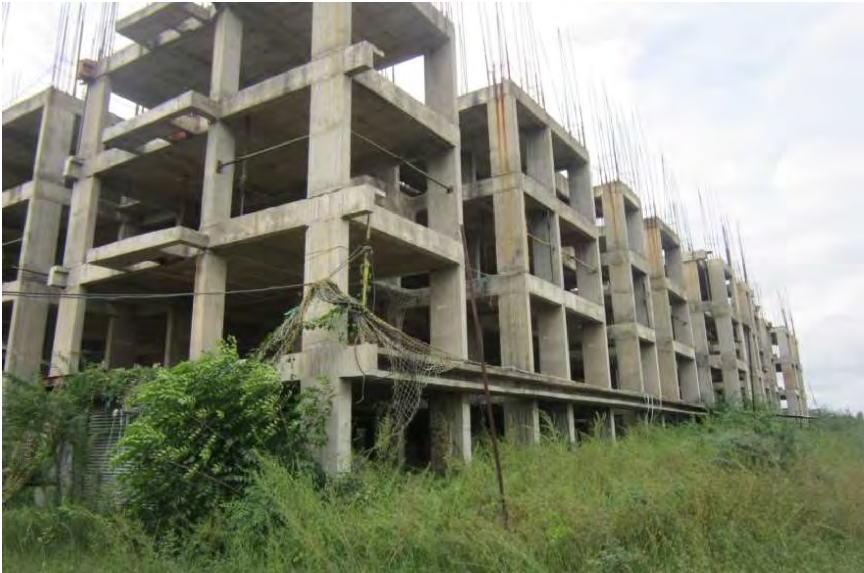
Block F – 4th floor slab pour 1 and pour 2 completed
