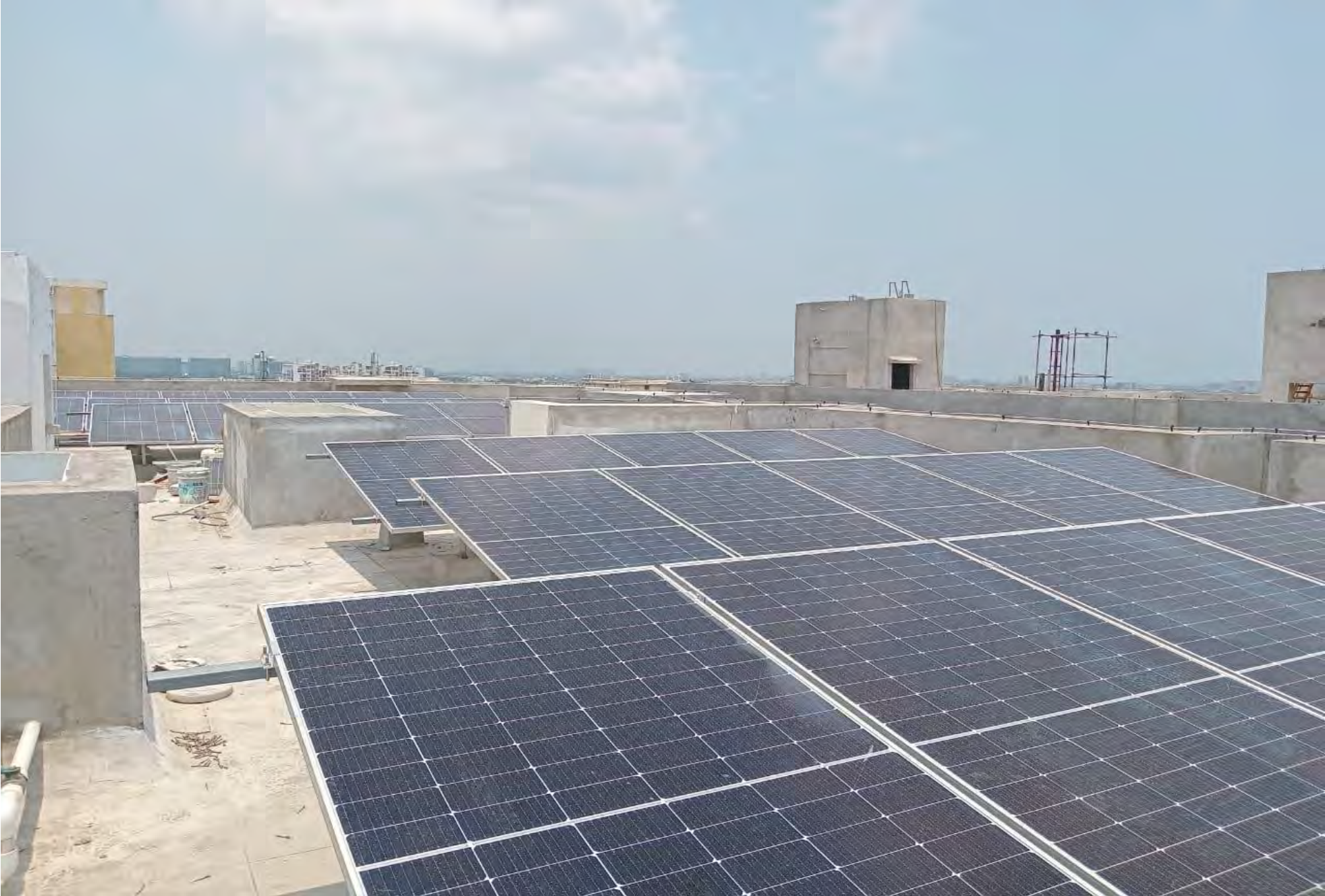
E2 Terrace solar panels fixed .
