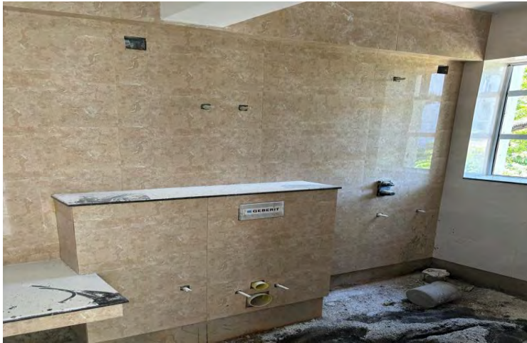
2A – T3 Toilet
