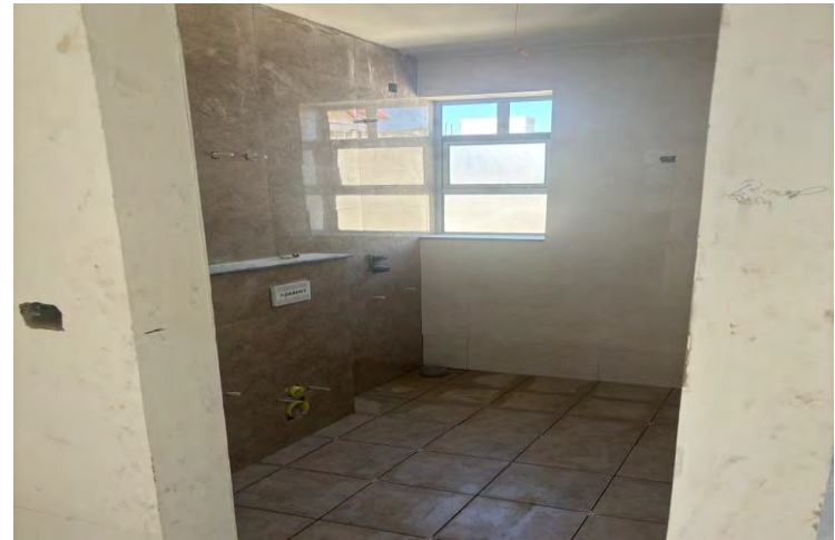
4B - T2 Toilet
