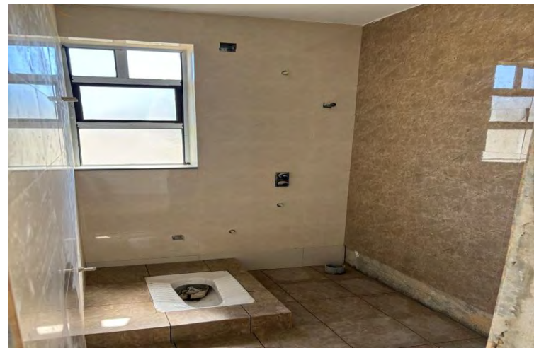
3B— T3 Toilet
