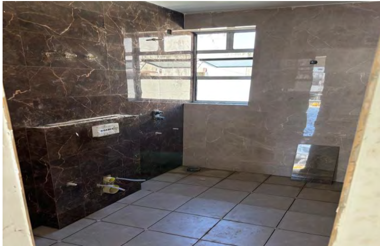
3B T2 Toilet
